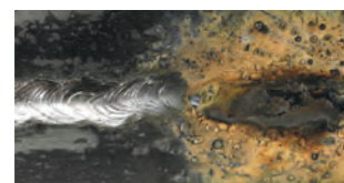
Saldatura su ferro / Welding on iron
